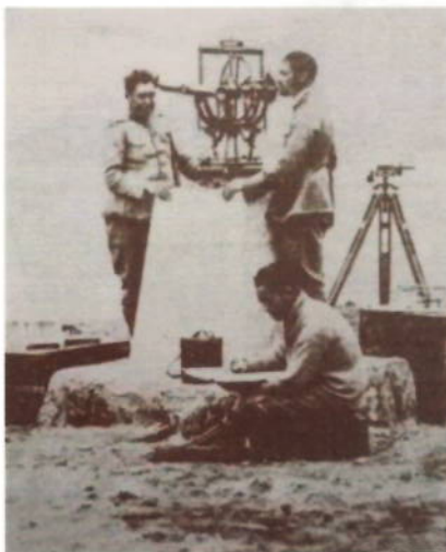
Ilustración 4: Geodesia convencional Fuente: IGM
