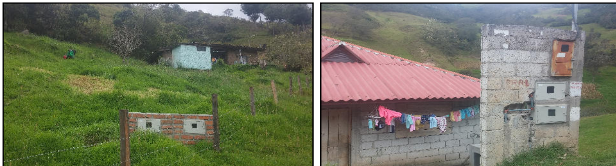
Imagen 23: Medidores de varias viviendas en la comunidad San Agustín de la parroquia Victoria del Portete.
