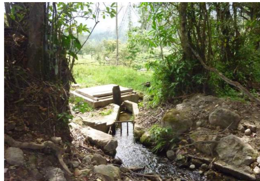
Vertiente de agua potable Cachi
